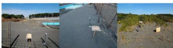
Aエリア設置状況
